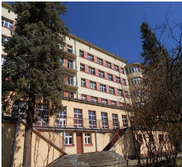
Elewacja z częściowo starymi oknami przed modernizacją oraz nowe okna zastępujące luksfery.
