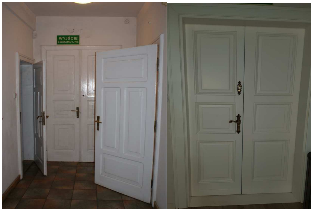
Drzwi przed i po modernizacji.
