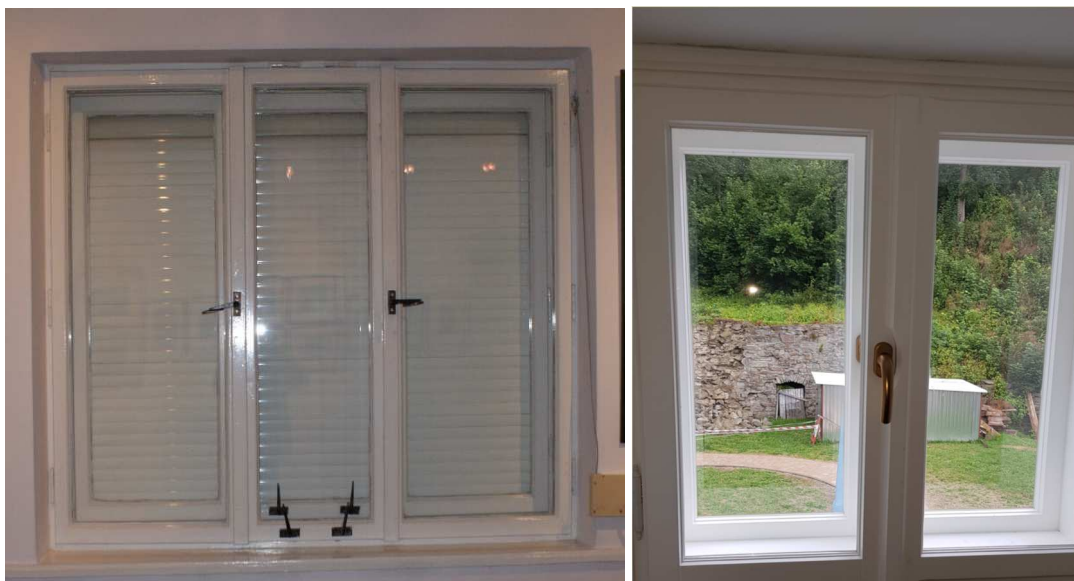
Okna skrzynkowe drewniane przed i po modernizacji.
