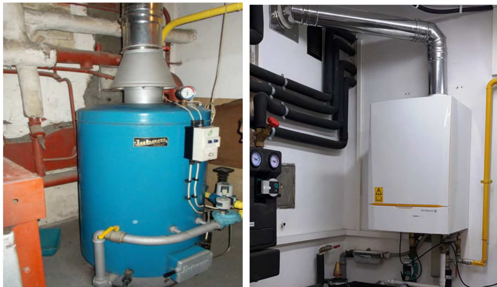
Modernizacja kotłowni gazowej ( zdjęcie przed i po modernizacji).
