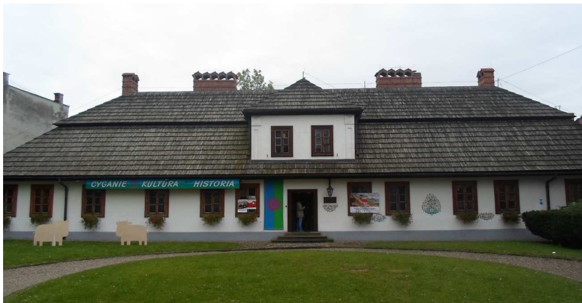
Widok na ścianę frontową budynku przed modernizacją.
