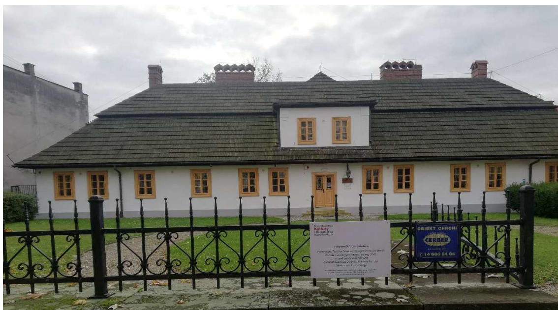
Widok na ścianę frontową budynku po modernizacji. Widoczne wymienione okna i drzwi zewnętrzne.
