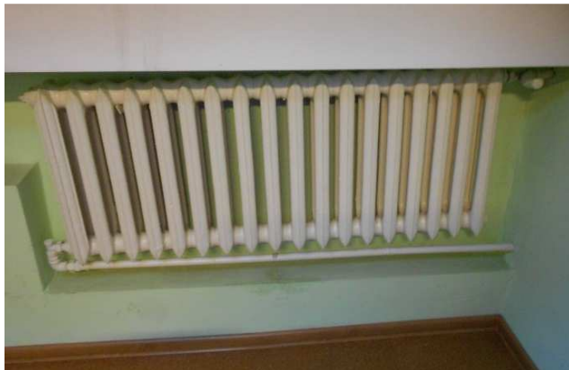
Stare grzejniki żeliwne oraz wymienione nowe wraz z zaworami termostaticznymi.
