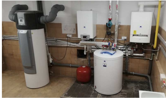
Stary kocioł gazowy zakwalifikowany do wymiany, oraz nowy z pompą ciepła.
