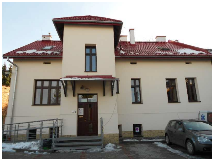
Tylna ściana budynku Pogotowia z wcześniej wykonaną izolacją termiczną.
