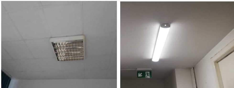
Stare oświetlenie oraz wymienione nowe energooszczędne.
