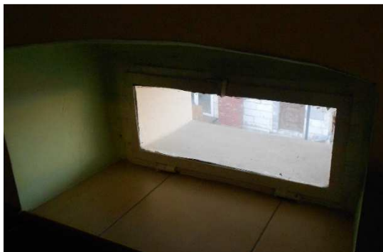
Stare drewniane okno zlokalizowane na 1 piętrze budynku, oraz fragment ściany po zamurowaniu okna.
