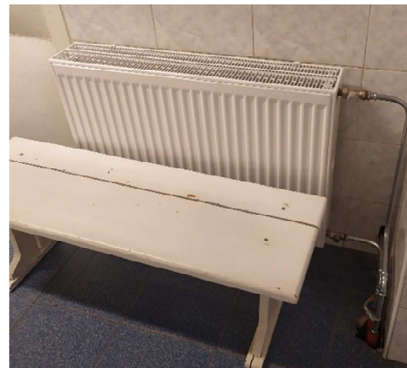
Stare grzejniki żeliwne oraz wymienione nowe wraz z zaworami termostaticznymi.
