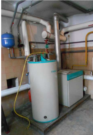
Stary kocioł gazowy zakwalifikowany do wymiany, oraz nowy z pompą ciepła.
