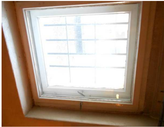
Drewniane stare okno w piwnicy oraz nowe z PCV po modernizacji.
